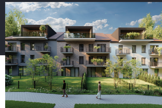
Widok budynku od tyłu
